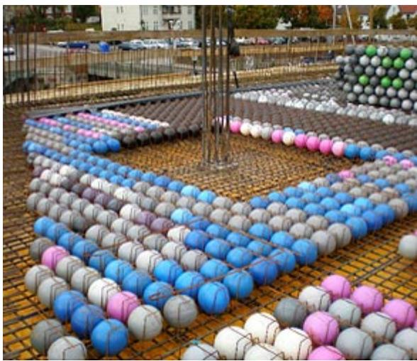
می شود. در نهایت مقطع دال به صورت I شکل با جان با ضخامت متغیر در این نوع سقف در زمینه های سازه، انرژی، حریق و آکوستیک در مرکز تحقیقات ساختمان و مسکن بررسی شده و کاربرد آن در حیطه الزامات تدوین شده مورد تایید می باشد.
