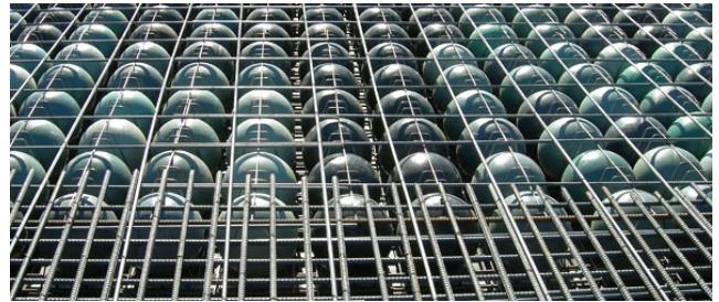
در روند اجرای این سیستم سقف، ابتدا پس از آرماتور گذاری لایه زیرین، قفسه هایی از گویهای کروی شکل با فاصله کنار هم روی شبکه آرماتور زیرین قرار گرفته و پس از آرماتور بندی لایه فوقانی، بتن روئی ریخته
