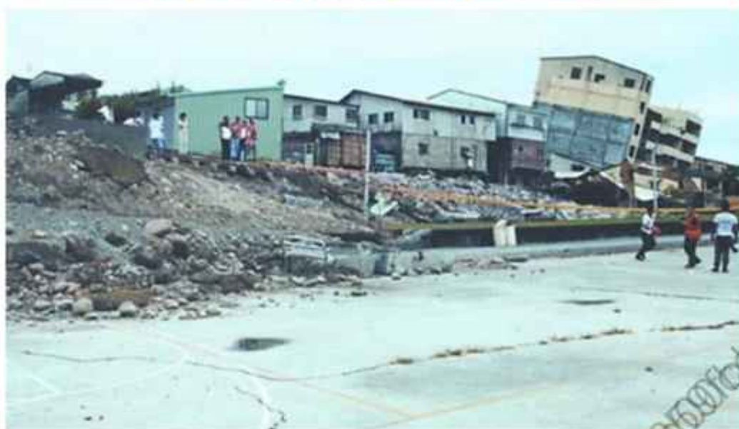
شکل ۸. اسکارپ گسلی و پیامد ساخت و ساز در محدوده اجتناب از گسل [۳۱]
