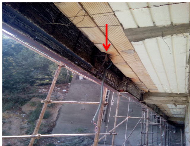
شکل ۲۳ و ۲۴. شکستن بتن کاور تیرچه و گرفتن اتصال برای ساپورت نما و همچنین شکستن کاور تیر برای اتصال اسکلت آسانسور به آن مجاز نمی باشد.
