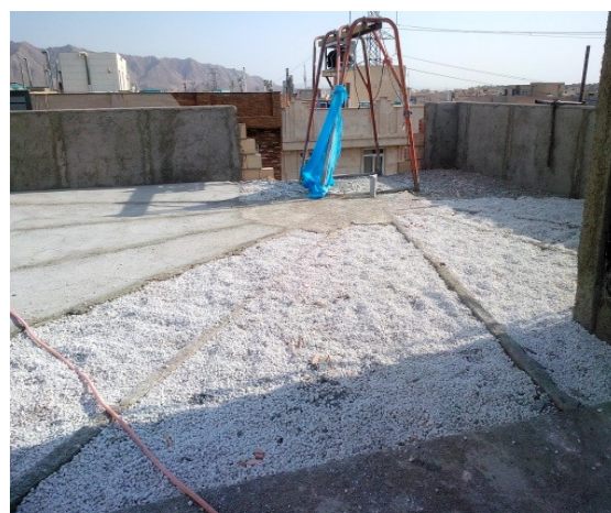
شکل ۲۹ و ۳۰. استفاده مناسب از مصالح سبک در کفسازی بام.
