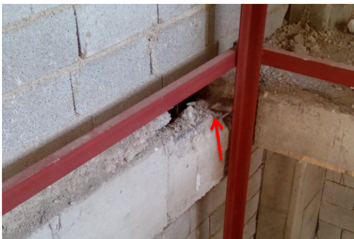
شکل ۲۳ و ۲۴. شکستن بتن کاور تیرچه و گرفتن اتصال برای ساپورت نما و همچنین شکستن کاور تیر برای اتصال اسکلت آسانسور به آن مجاز نمی باشد.
