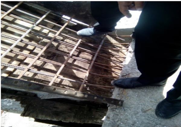
شکل ۹ و ۸. اجرای نامناسب آرماتوربندی دال راه پله به صورت تک شبکه
