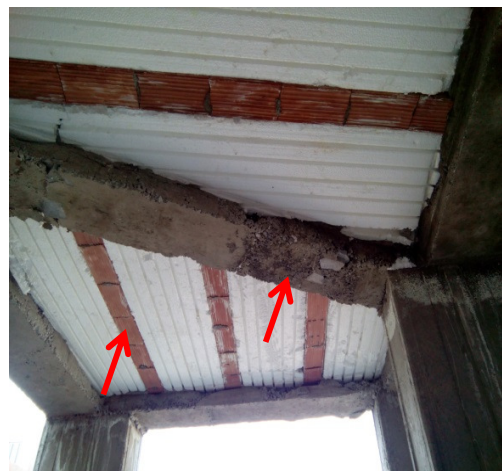
شکل ۱۳. استفاده از تیرچه فندوله دار و کرمو شدن بتن تیر. شکل ۱۴. اجرای نامناسب قالب بندی اطراف ستون.
