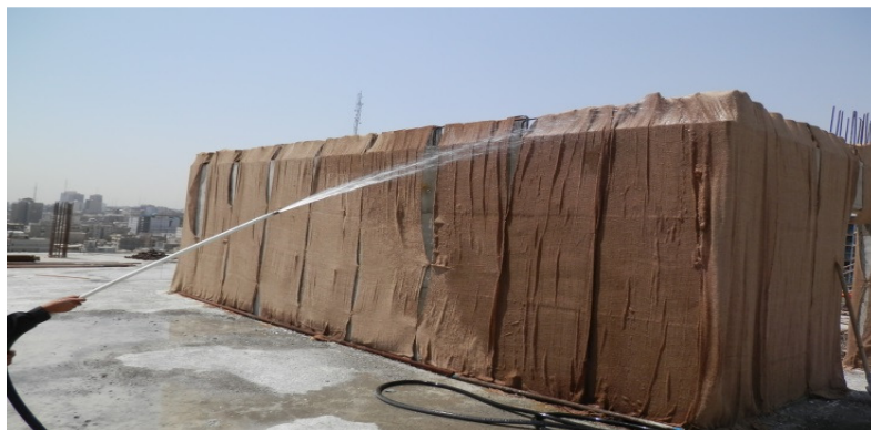
شکل ۱۱. عمل آوری بتن در هوای گرم (بهتر است جهت جلوگیری از فرار رطوبت بتن از روی گونی چتایی نایلون بی رنگ کشیده شود).
