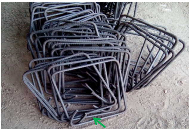
شکل ۳ - رعایت زاویه ۱۳۵ درجه خم انتهای خاموت طبق نقشه
