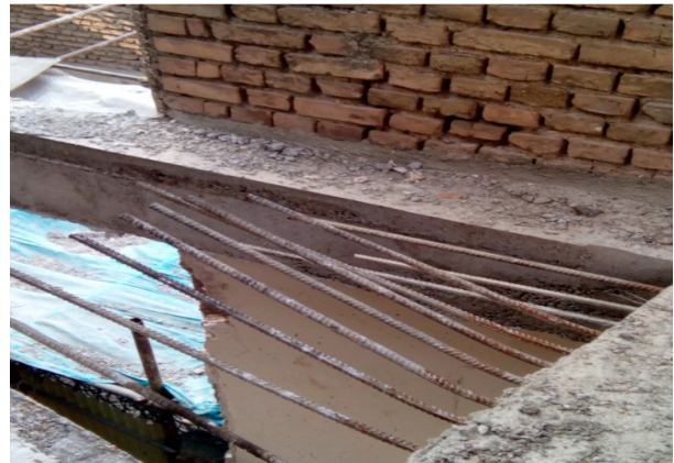
شکل ۹ و ۸. اجرای نامناسب آرماتوربندی دال راه پله به صورت تک شبکه
