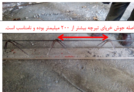
شکل ۱۶. فاصله زیگزاگ تیرچه ها بیشتر از ۲۱۵ میلیمتر و نامناسب است. شکل ۱۷. استفاده از تیرچه فوندوله ای و خیز نامتعارف آن در نزدیک تیر.
