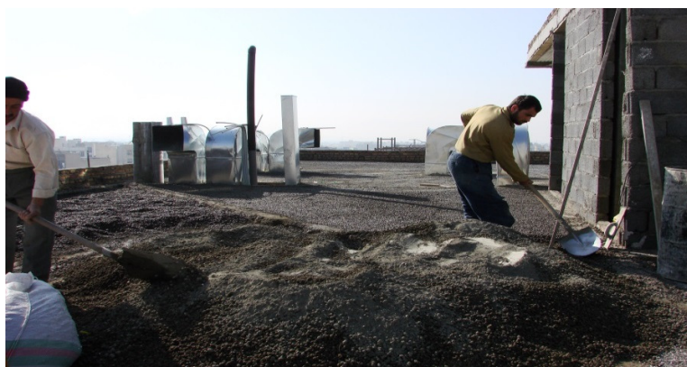
شکل ۲۹ و ۳۰. استفاده مناسب از مصالح سبک در کفسازی بام.
