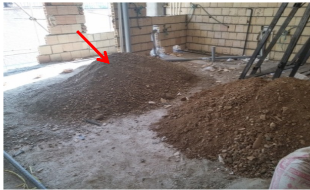
شکل ۲۷ و ۲۸. استفاده غیر مجاز از خاک مخلوط در کفسازی طبقات و بام بجای استفاده از مصالح سبک مانند بتن با پوکه یا فوم بتن
