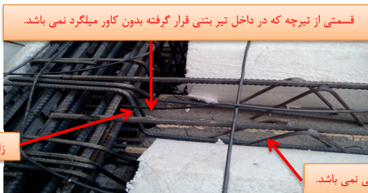
شکل ۲۰. نمونه ای از اشکالات اجرایی سقف تیرچه و بلوک
