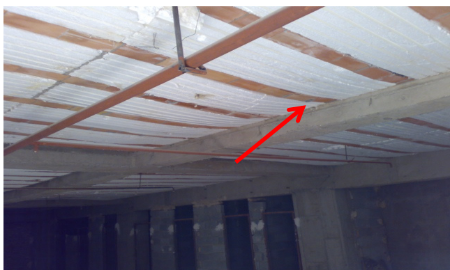
شکل ۱۶. فاصله زیگزاگ تیرچه ها بیشتر از ۲۱۵ میلیمتر و نامناسب است. شکل ۱۷. استفاده از تیرچه فوندوله ای و خیز نامتعارف آن در نزدیک تیر.
