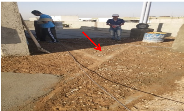
شکل ۲۷ و ۲۸. استفاده غیر مجاز از خاک مخلوط در کفسازی طبقات و بام بجای استفاده از مصالح سبک مانند بتن با پوکه یا فوم بتن
