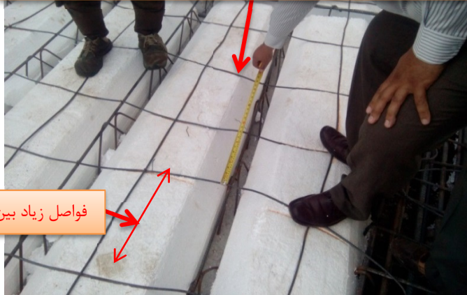
شکل ۲۲. اجرای نامناسب آرماتور حرارتی سقف
