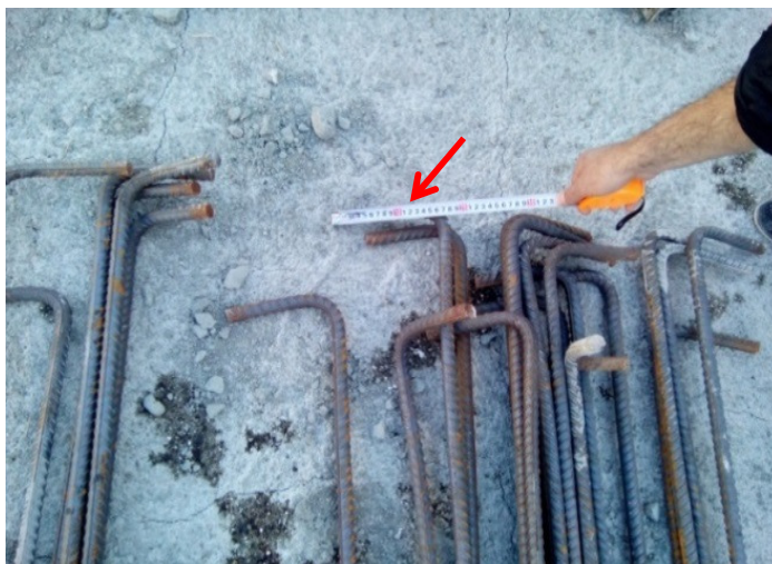
شکل ۴. طول خم انتهایی آرماتور کمتر از (12db + شعاع خم) است.
