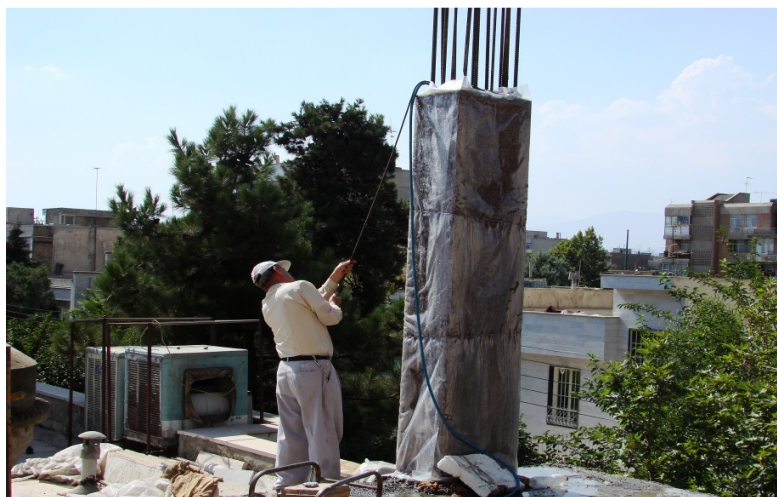
شکل ۱۱. عمل آوری بتن در هوای گرم (بهتر است جهت جلوگیری از فرار رطوبت بتن از روی گونی چتایی نایلون بی رنگ کشیده شود).
