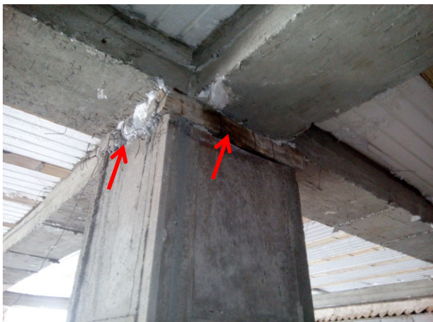
شکل ۱۳. استفاده از تیرچه فندوله دار و کرمو شدن بتن تیر. شکل ۱۴. اجرای نامناسب قالب بندی اطراف ستون.
