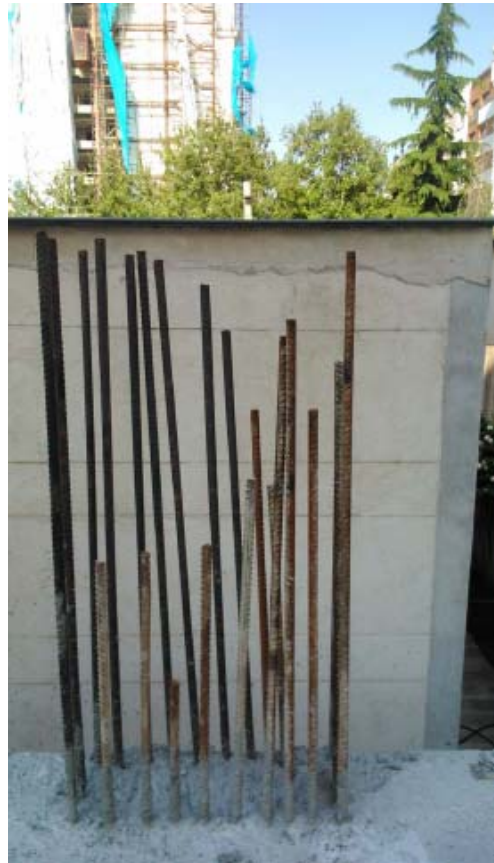
طول میلگردهای انتظار ستون بسیار نامنظم و اغلب کمتر از مقدار لازم
