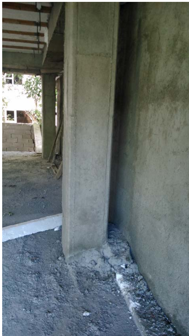
پر شدن درز انقطاع با مصالح سخت بتنی
