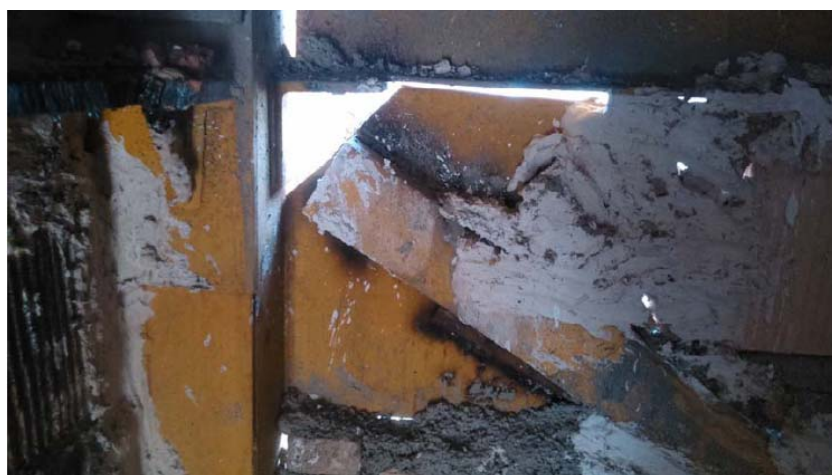
عدم اتصال بادبند به سازه
