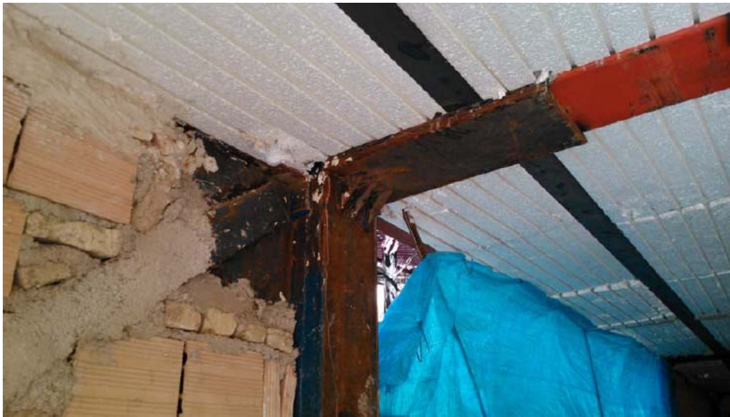
عدم محافظت اجزای باربر سازه در برابر خوردگی
