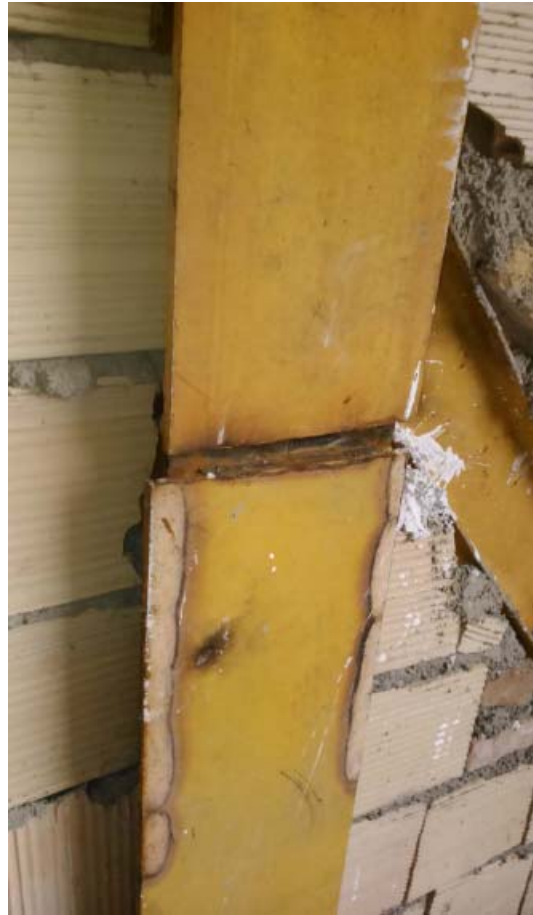
عدم پیوستگی ورق تقویتی ستون
