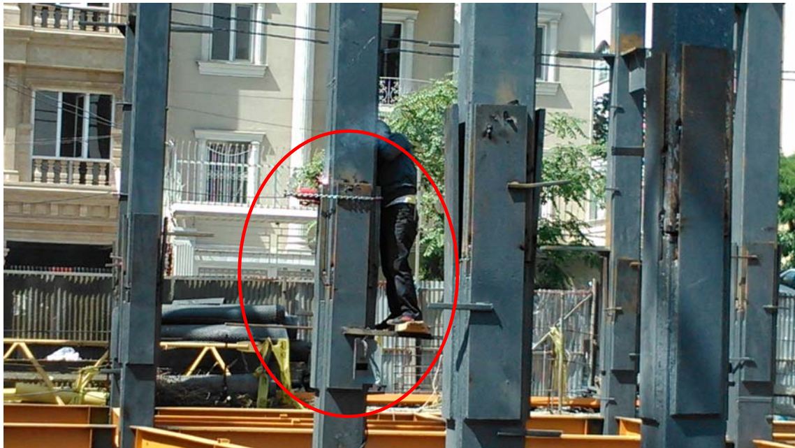
خم سرد ورق اتصال وصله ستون به ستون و ایجاد تنش‌های پسماند پس از جوشکاری
