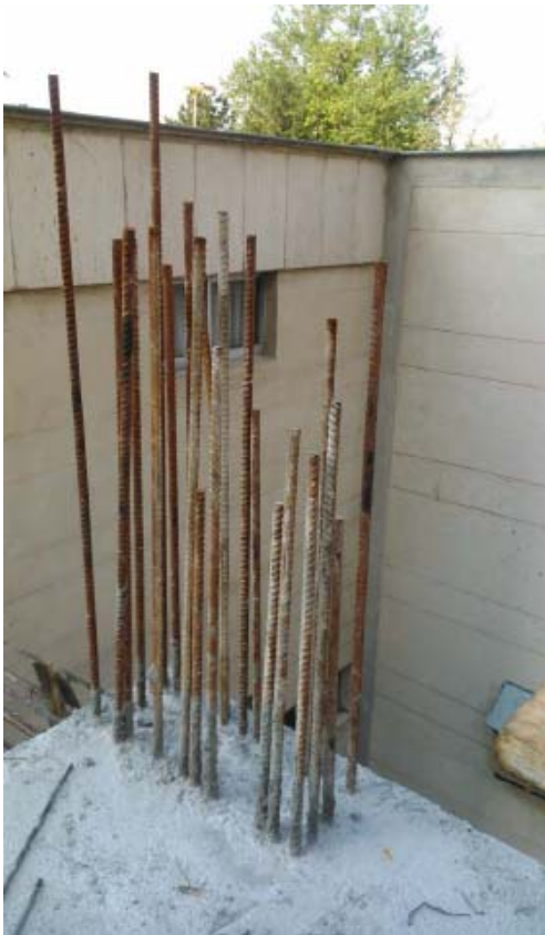
طول میلگردهای انتظار ستون بسیار نامنظم و اغلب کمتر از مقدار لازم
