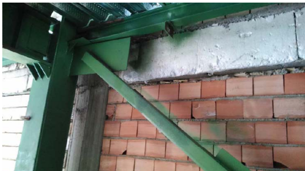
عدم اتصال ورق بادبند به تیر
