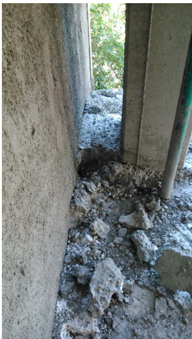
پر شدن درز انقطاع با مصالح سخت بتنی
