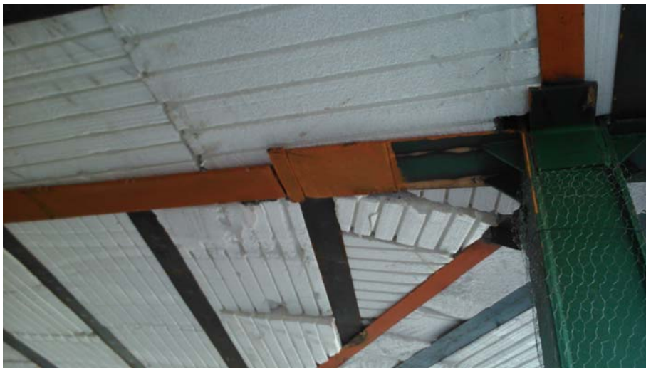
ورق‌های ناپیوسته جهت تقویت تیر در تکیه‌گاه در اتصال گیردار تیر به ستون
