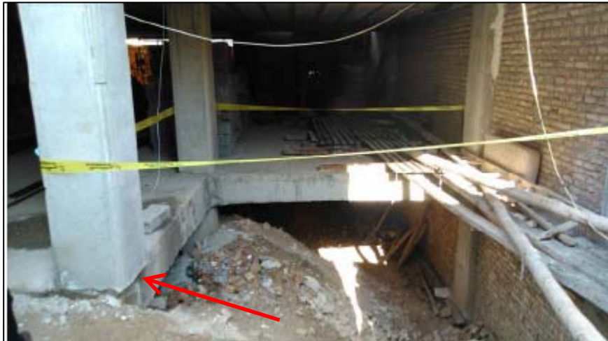
قالب بندی غیر اصولی ستون - خروج از مرکزیت
