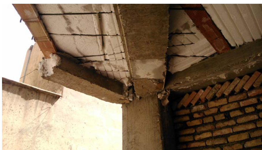
قالب بندی و بتن ریزی غیر اصلی اتصال تیر به ستون
