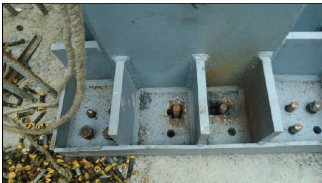
اصلاح غیر اصولی محل سوراخ بولت‌های اتصال صفحه ستون به فونداسیون با دستگاه هوا برش
