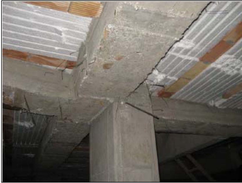
خروج از مرکزیت غیر مجاز تیر نسبت به ستون
