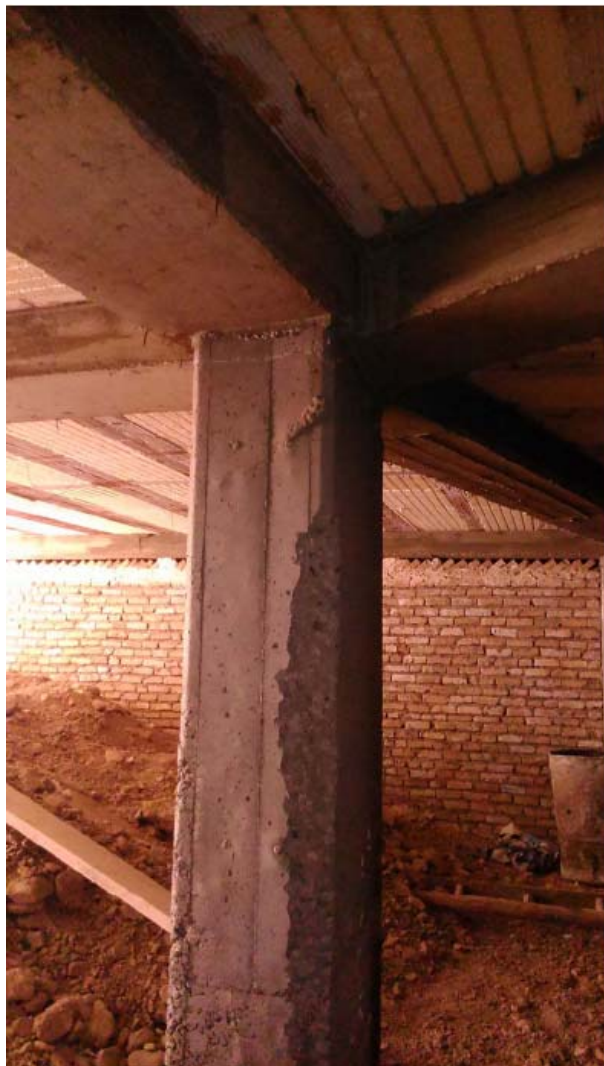
تراشیدن لبه ستون و کاهش مقطع به واسطه تامین شعاع چرخش خودرو در پارکینگ
