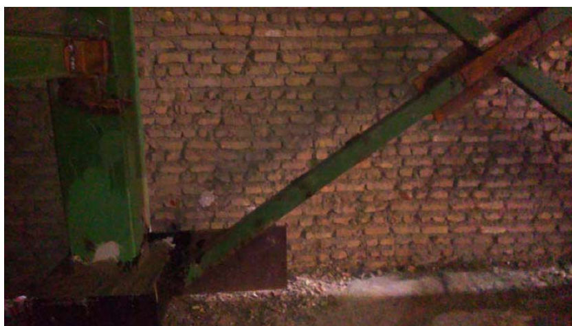
عدم تناسب ورق اتصال بادبند با ستون و صفحه ستون
