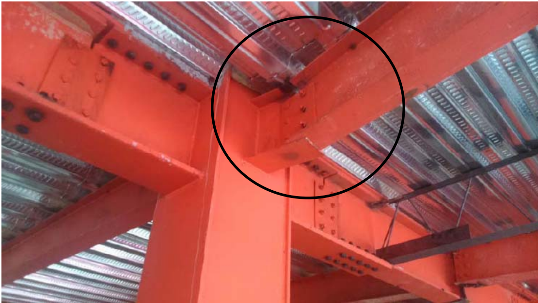
اتصال پیچ و مهره‌ای با ورق اتصال دو عضو غیر هم راستا
